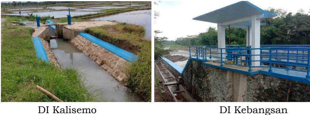
Gambar 2.28. Rehabilitasi Jaringan Irigasi Permukaan Wewenang Kabupaten Tahun Anggaran 2022
