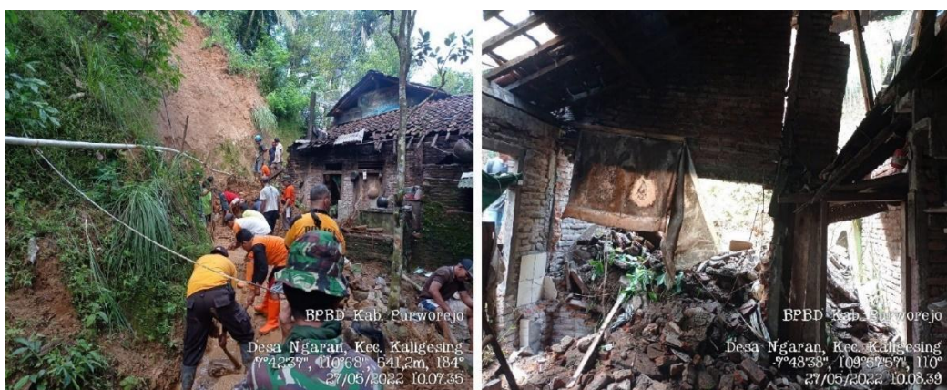
Gambar 2.30. Penanganan Tanah Longsor
