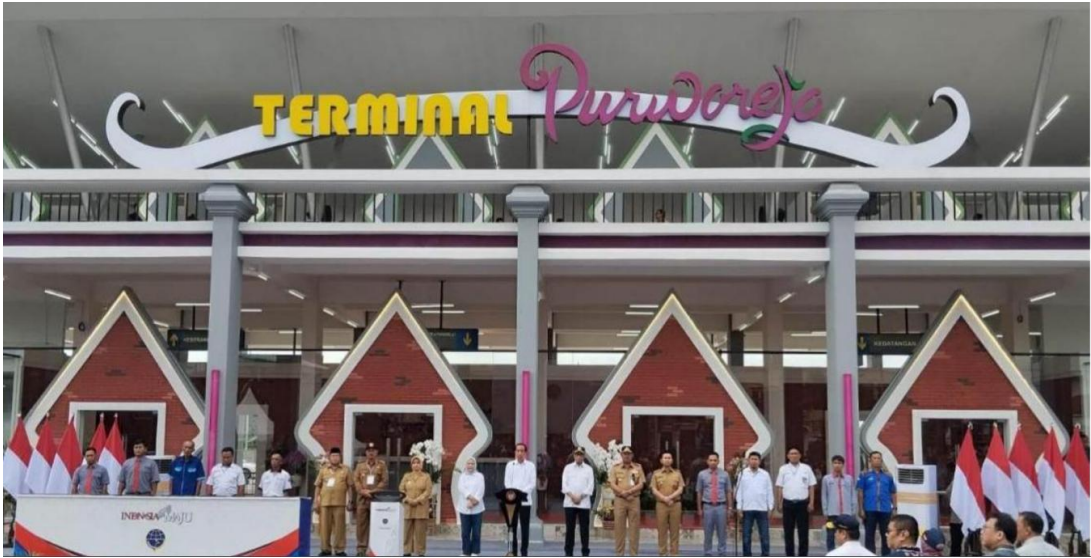
Gambar 2.40. Terminal Tipe A Purworejo Sumber: Survey Primer, 2025
