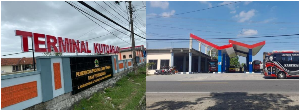
Gambar 2. 89 Terminal Tipe B Kutoarjo Sumber: Survei Primer, 2024
